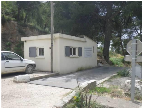
Accueil du site et bascule
